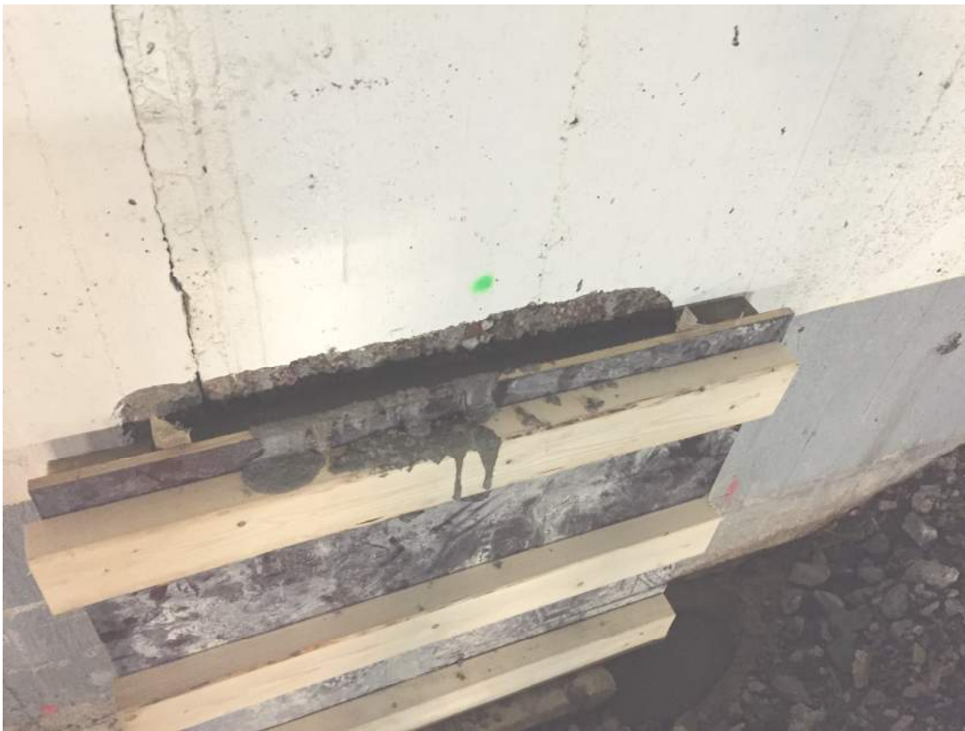
Form för att gjuta på en väggpelare på nedre plan.
