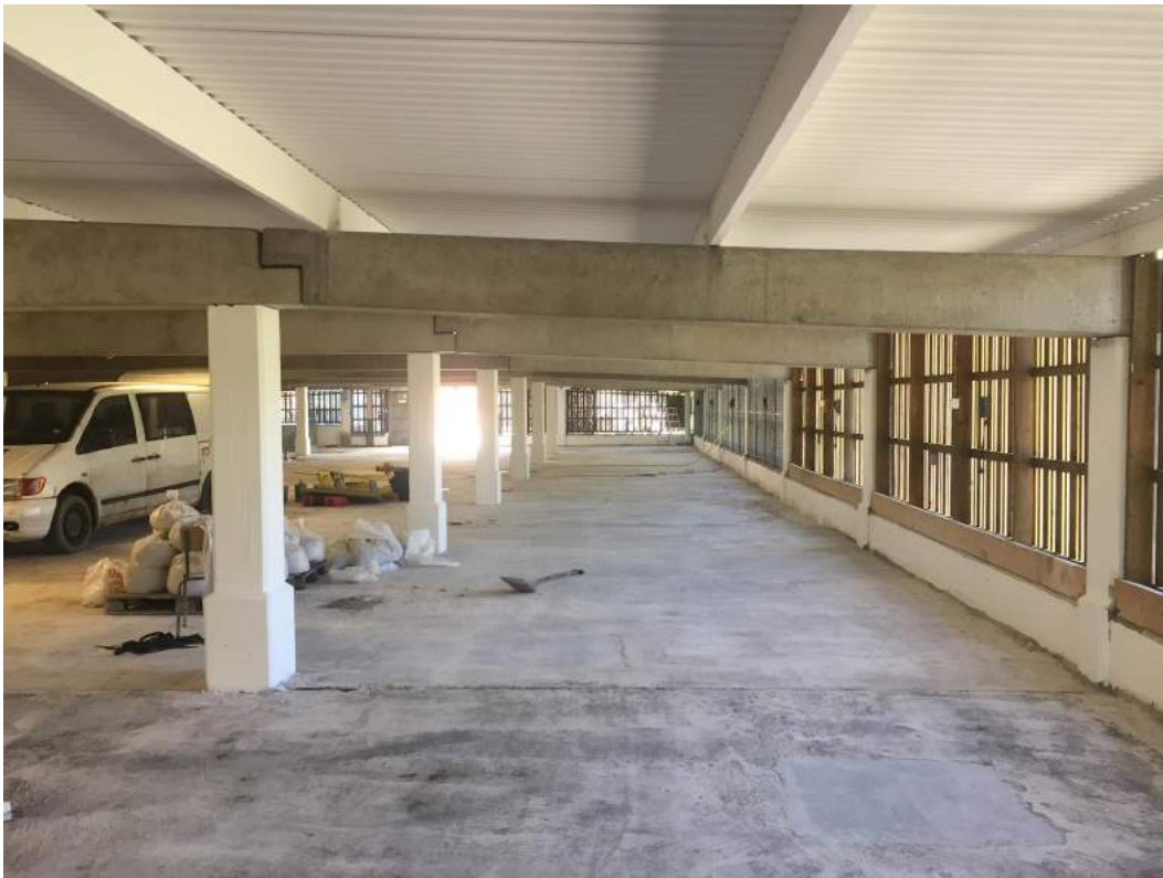
Målat tak + träbalkar + betongytor, övre plan
