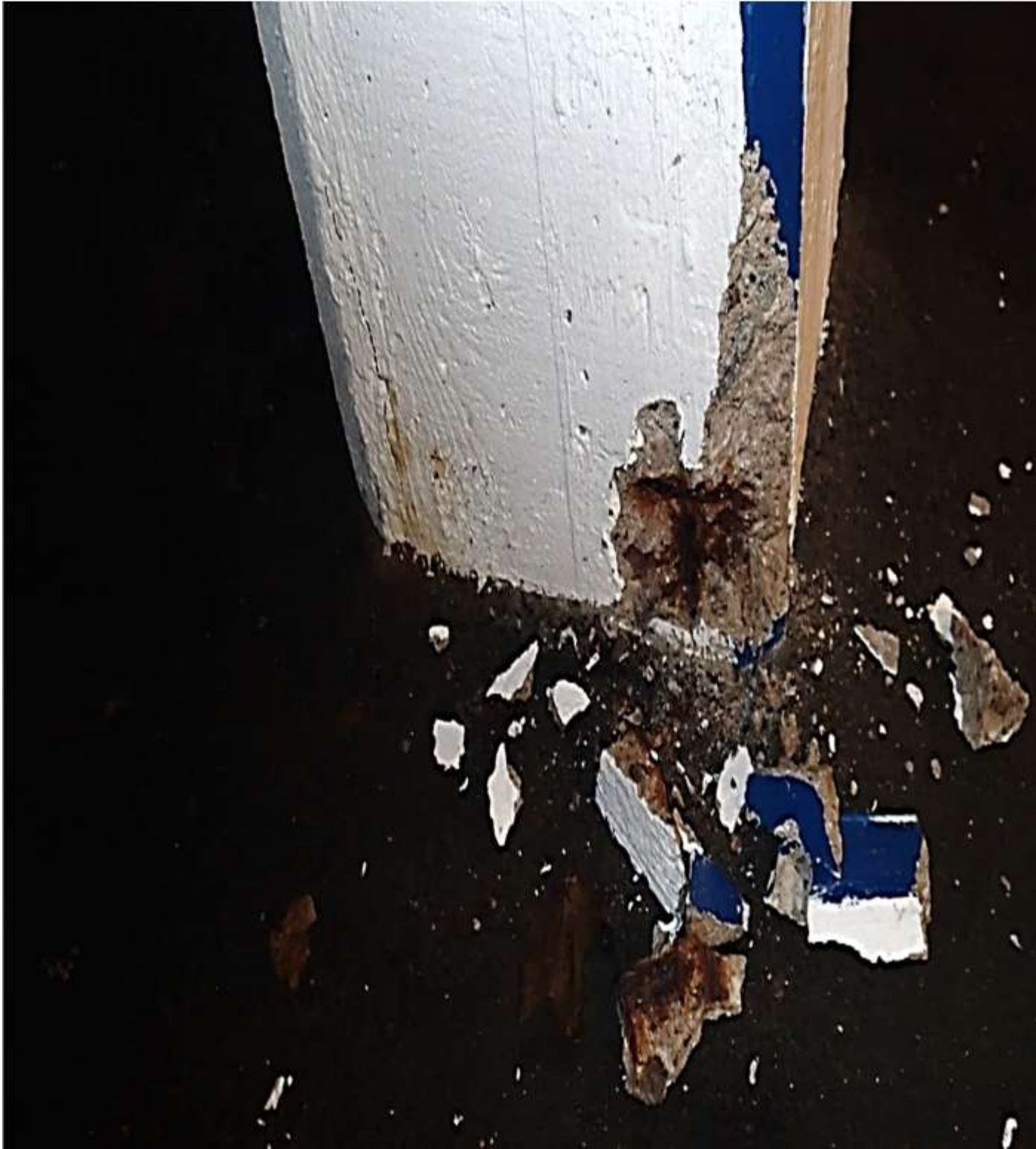
BILD 6 Armeringskorrosion pelarfot
